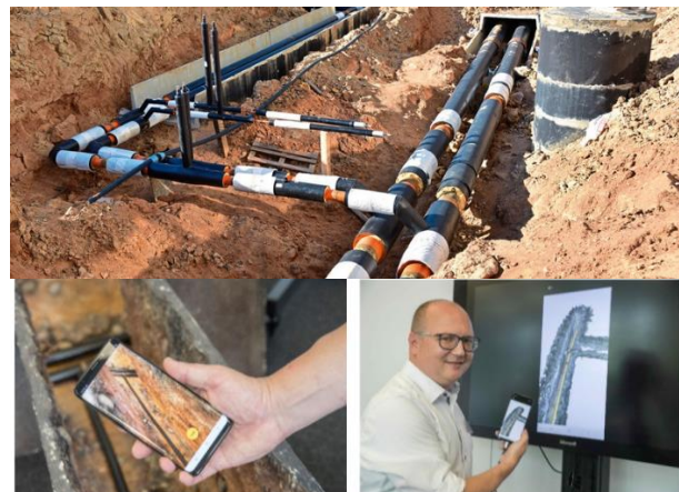
Abbildung 21: Datenerfassung mittels einem handelsüblichen Mobiltelefons (Fraunhofer IPM, 2020)
