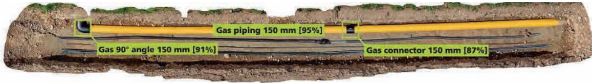
Abbildung 22: Erkennung der Objekte mittels KI Ansatz - Durchmesser der Rohre und in Klammern die Wahrscheinlichkeit des neuronalen Netzes (Fraunhofer IPM, 2020)
